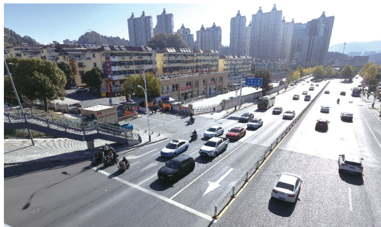
14日起,重庆路林荫大道一号线立交桥下通行方式调整。
