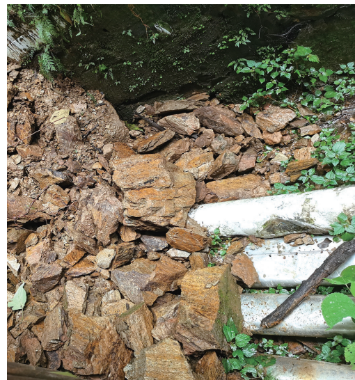
塌方体压坏水管。
