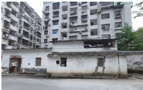
右侧的3间违建房。
