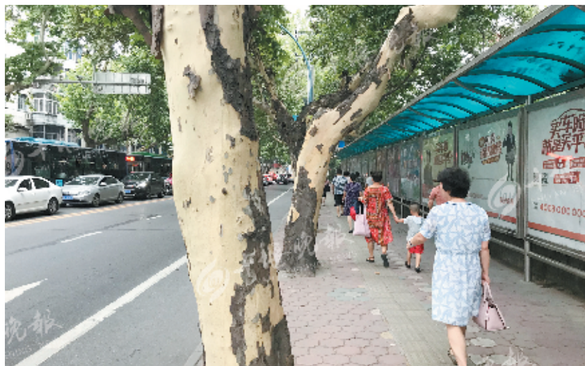
车城西路两旁的法国梧桐大面积脱皮。
