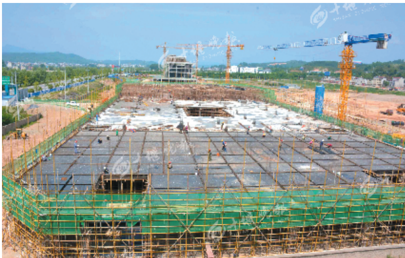
鄂西北物流集疏配送中心施工现场,工人正加紧建设。
