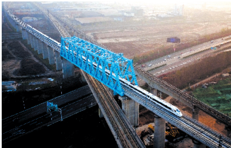
12月6日,西成高铁由西安北站驶出的列车经过西成高铁跨西宝高铁特大桥。该桥是出西安北站的第一座特大桥。
