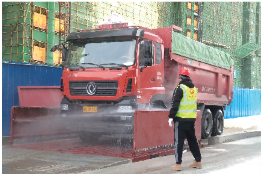
每一辆渣土车驶出工地都要对车身进行清洁,车轮彻底冲洗。
