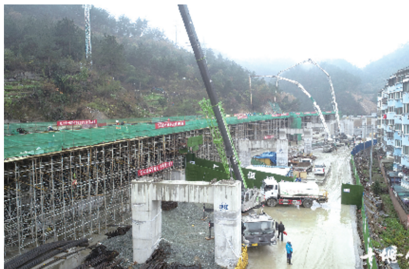
2020年11月25日,三峡路最长高架桥——艳湖高架桥首联现浇箱梁开始浇筑。
