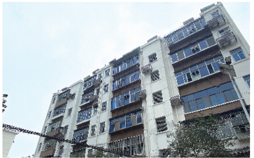
居民楼外墙重新粉刷焕然一新。
