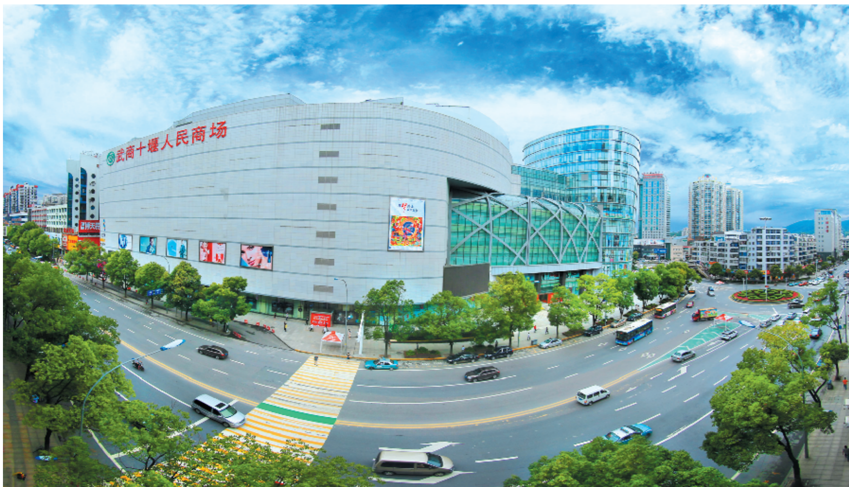
武商集团十堰人民商场成为十堰的地标性建筑之一。图/通讯员 李军
