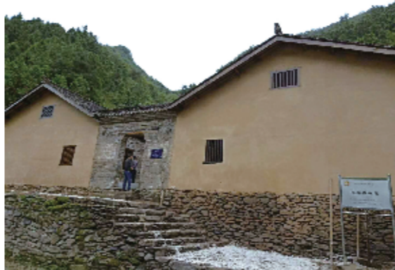
张振武故居已被修缮一新。
