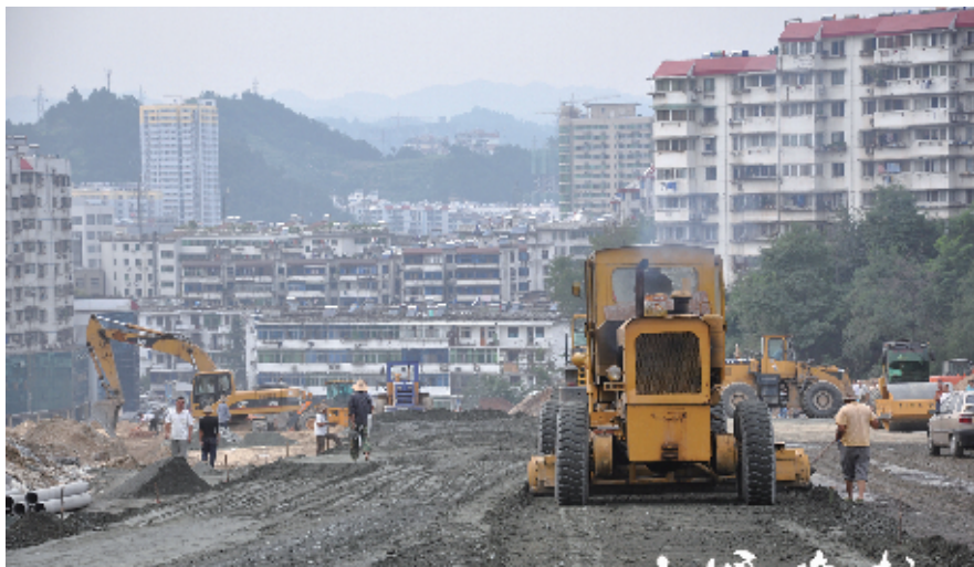
2010年9月,上海路建设施工现场。图/通讯员 袁平和
