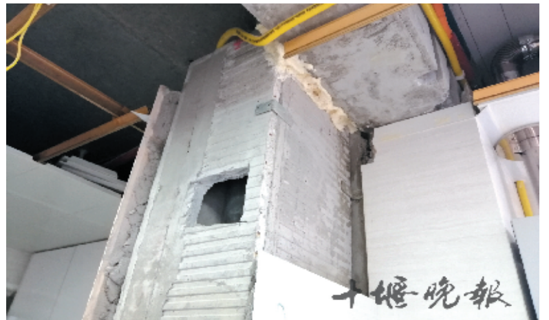
为查找油烟源头,厨房烟道部分的瓷砖已拆掉。
