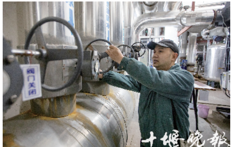
金港旺座小区工作人员检查小区供暖设施。
