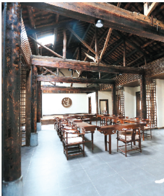
房屋主体改造形制参照武当官式建筑。
