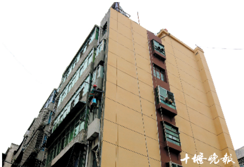
小区墙体重新粉刷焕然一新。
