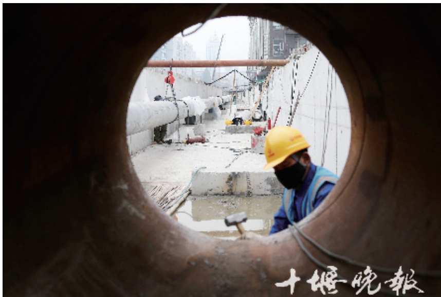
昨日,工人正在管沟内安装管道。图/记者 张启国
