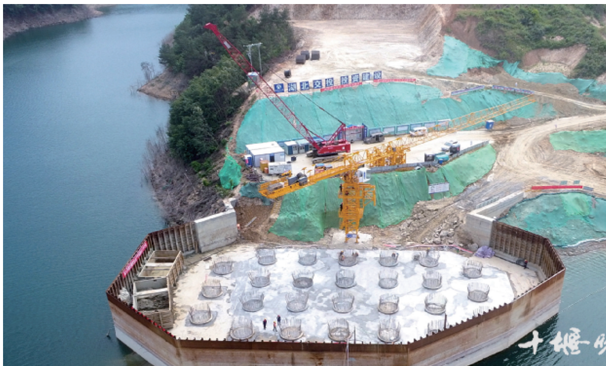
为了不让一滴污水流进水库，施工方建了两个大沉淀池。
