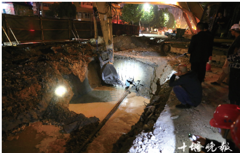
十堰东风中燃公司对受损管道开展抢修工作。
