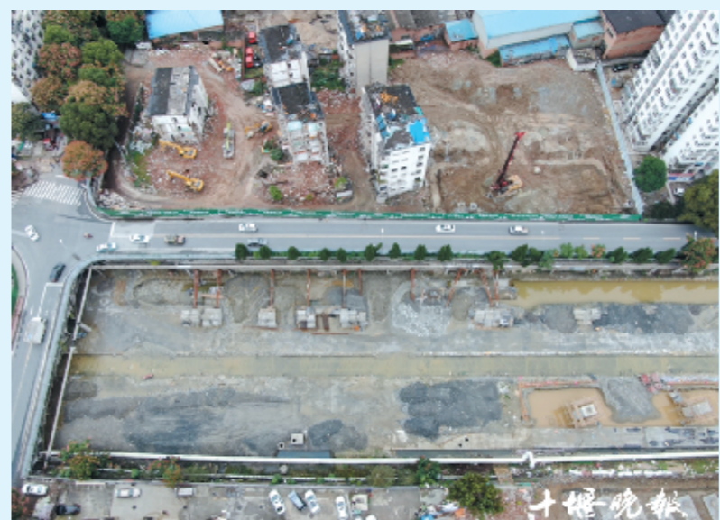
百二河桥梁工程长假期间也没有停工。
