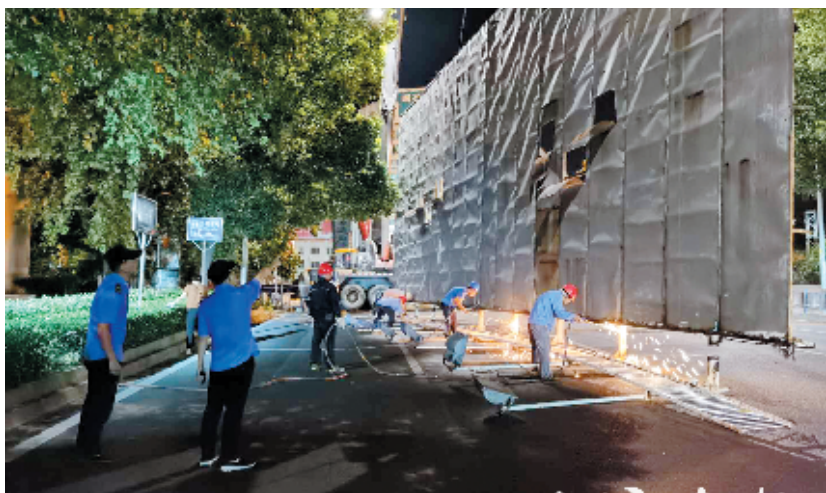
市城管支队对源园公园附近一大型单立柱广告牌进行拆除。
