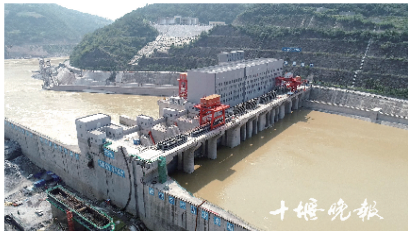
白河(夹河)水电站大坝预计明年5月底正式蓄水。
