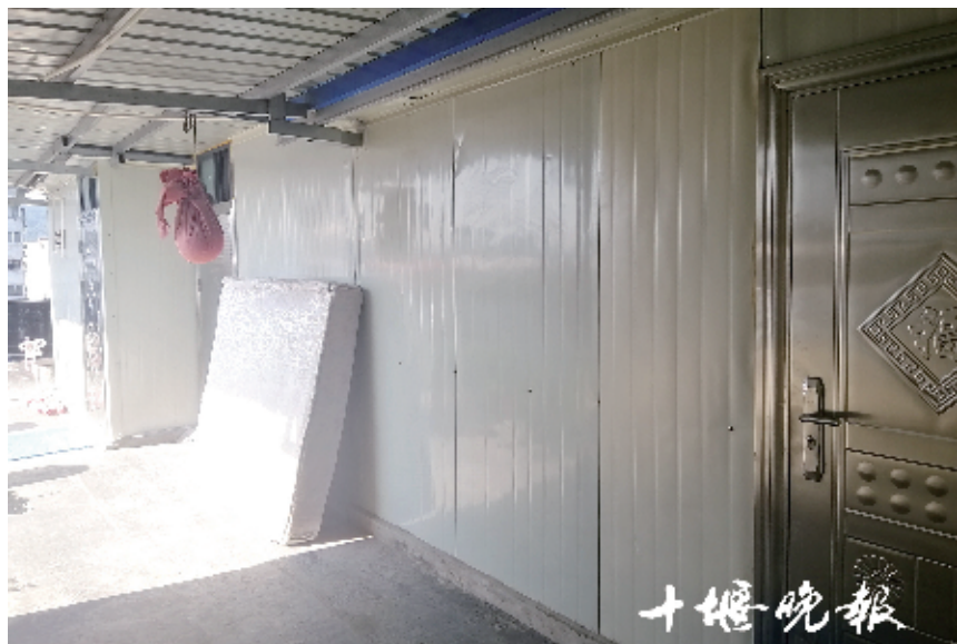
楼顶由彩钢瓦搭建的房间。
