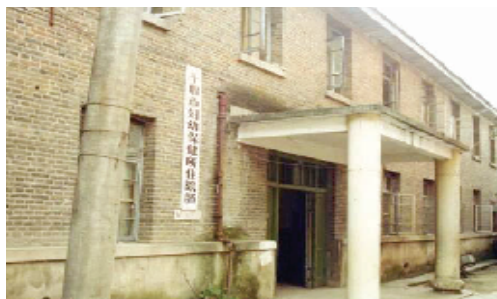
原十堰市妇幼保健所门诊住院楼。
