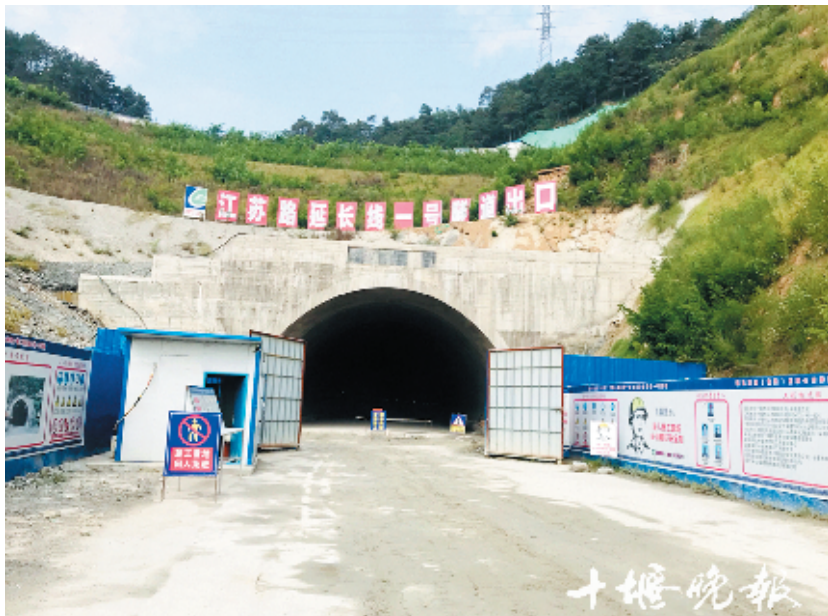
贯通后的江苏路延长线1号隧道出口干净整洁。
