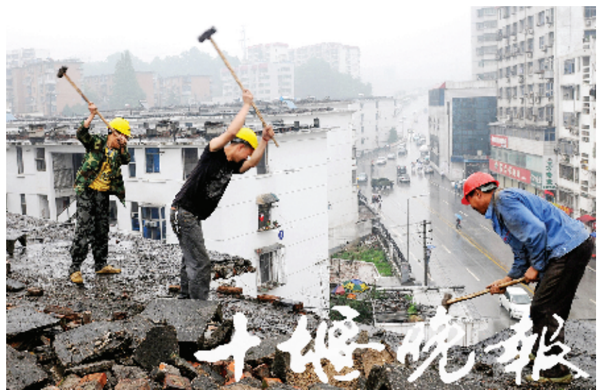
原上海路两侧的多幢楼房被拆除,对路面进行拓宽。
