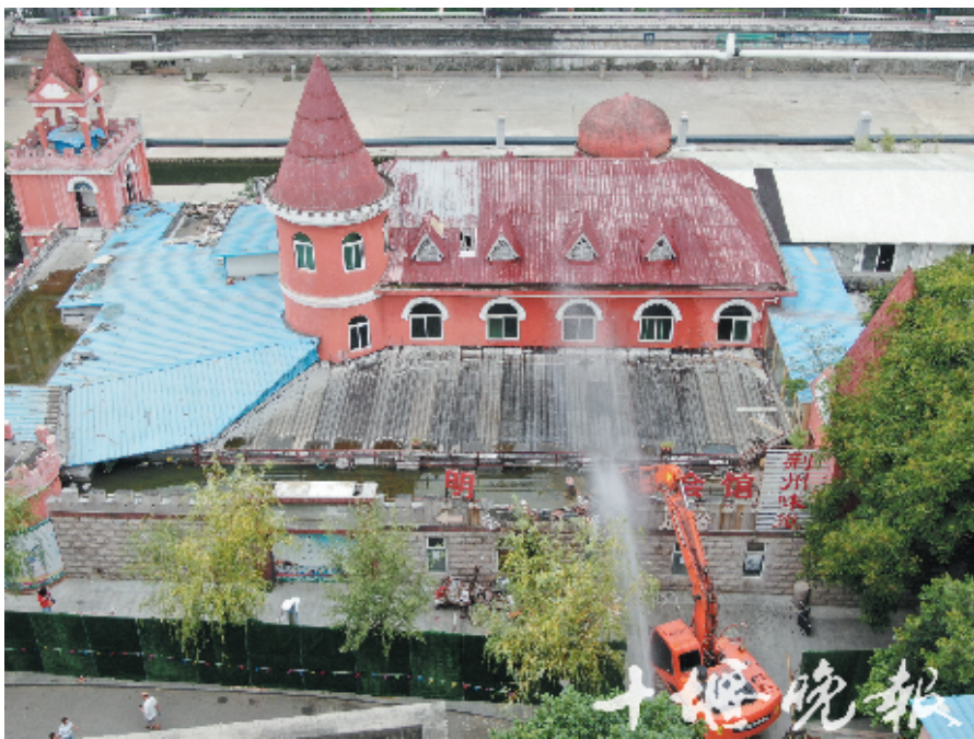
为了除尘环保,玫瑰宫一边拆除,一边洒水。
