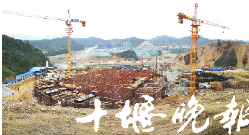
综合训练馆一层结构施工正加紧进行。
