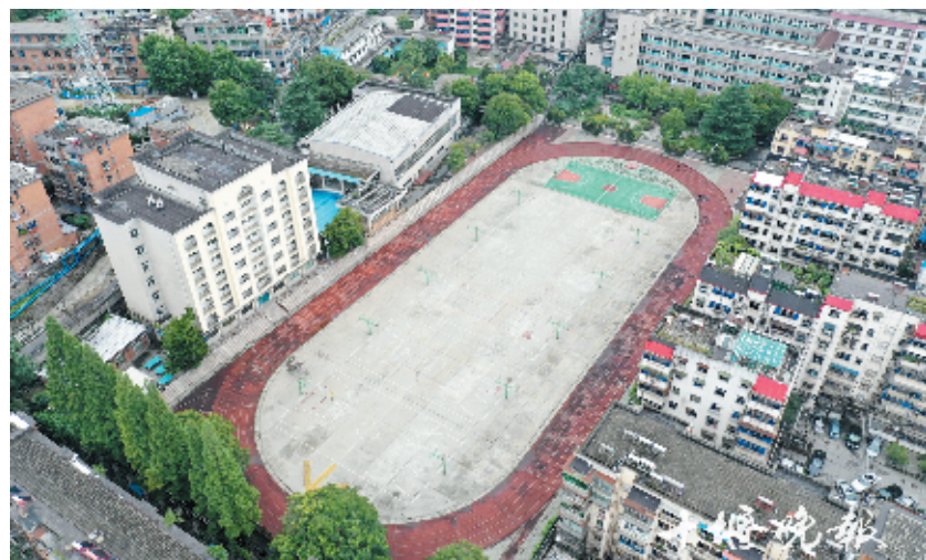
昨日,车城高中老校区装修改造正式开始施工。
