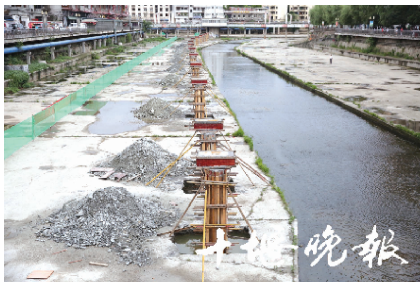
百二河河道开挖基坑铺设临时热网施工正在进行。
