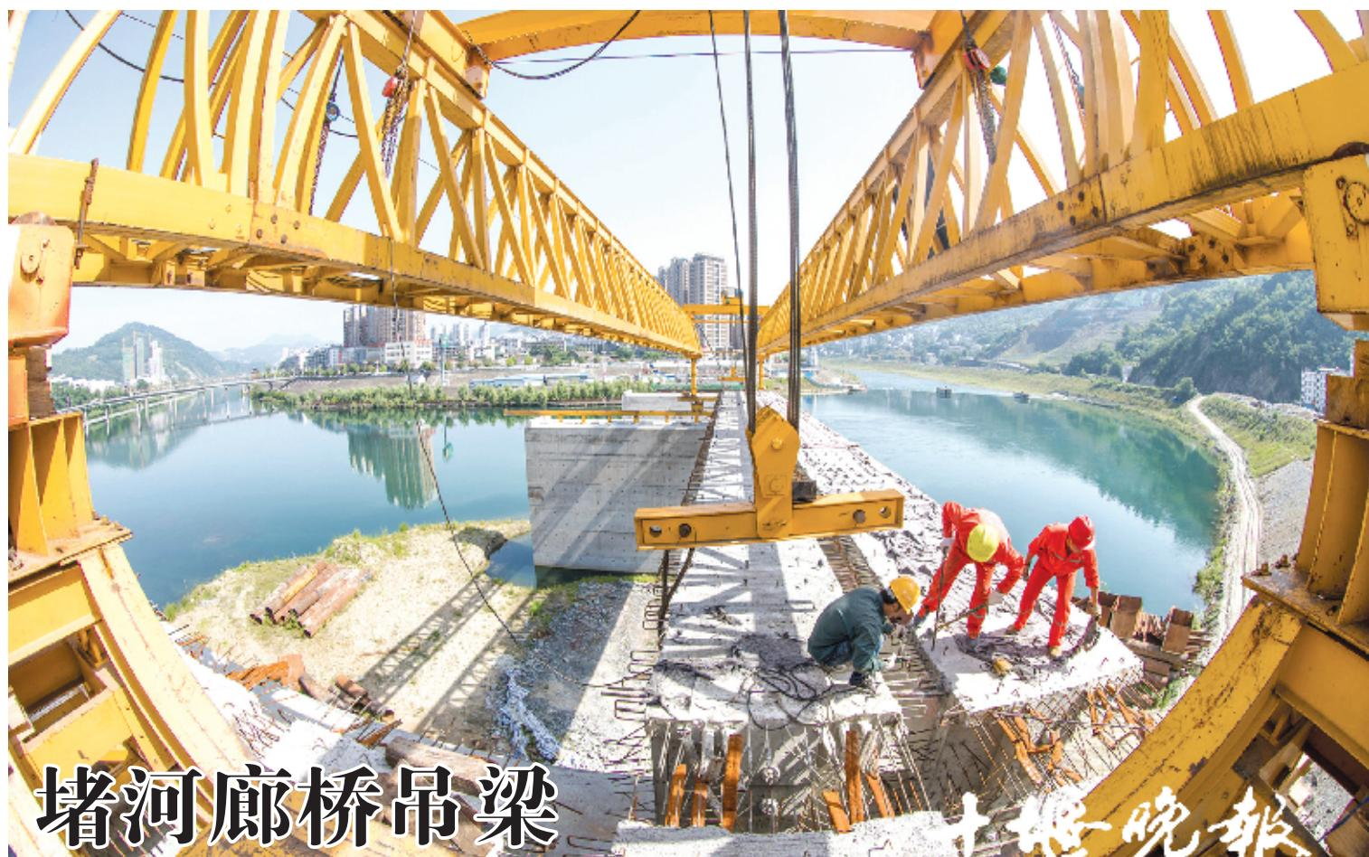
日前，施工人员在竹山县城关镇堵河廊桥吊装133吨预制梁。目前，堵河廊桥完成下部构造建设，开始架设预制梁，工程转入桥面铺设阶段。
