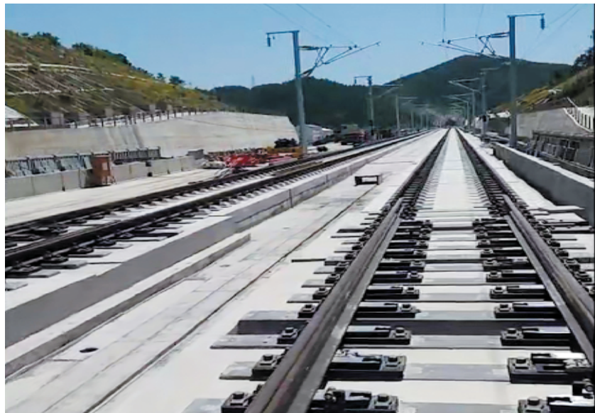
汉十高铁丹江口段首段铁轨开始铺设。
