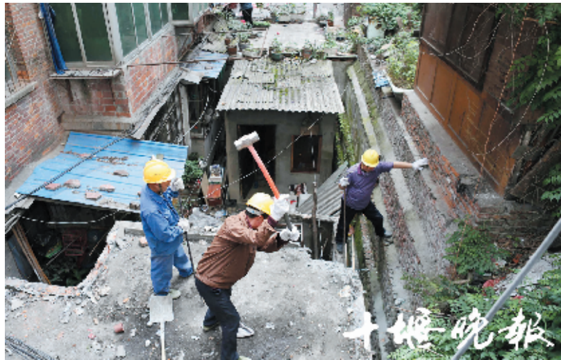
工作人员现场拆除违法建筑。
