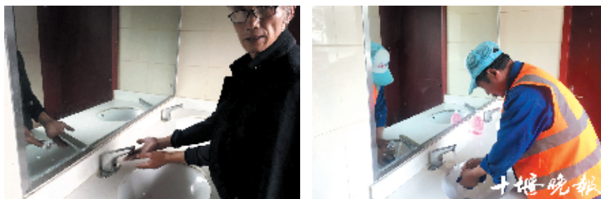
进站大厅的公厕里没有亮灯，洗手池也没水(回访前后)。
