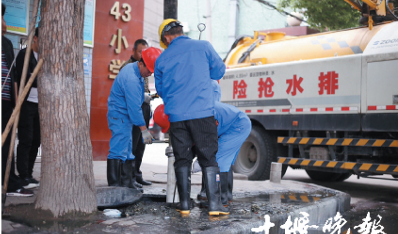
昨日下午,工作人员对堵塞管道进行抢修。
