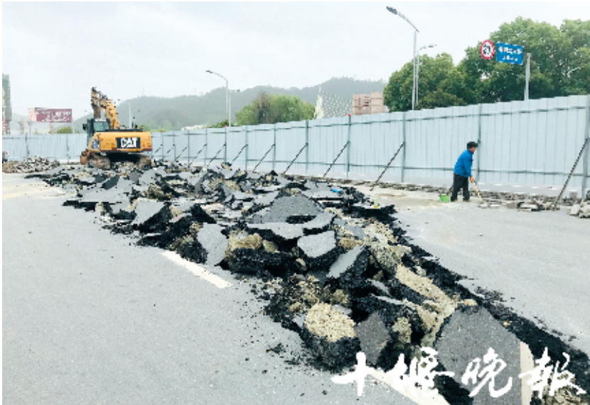
地下物流通道开挖路面。
