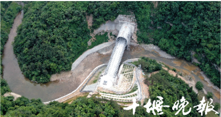
汉十高铁隧道剑河水库段。
