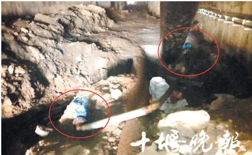
口径150毫米的自来水管,被人移花接木到了口径800毫米的管道上。
