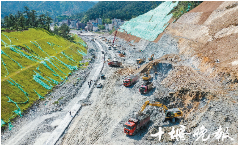
阳光大道二期工程正加紧施工。
