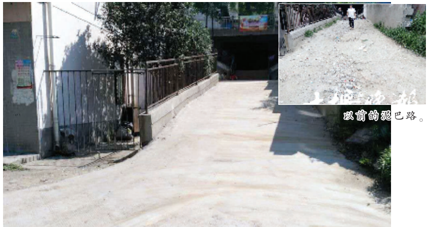
镜潭丽苑小区入口处已修成水泥路。
