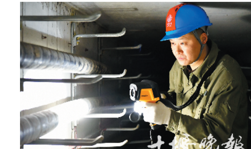
刘志华钻进电缆沟检查地下电缆。
