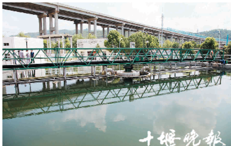
提标升级改造完工的六里坪镇污水处理厂日处理污水1.5万吨。
