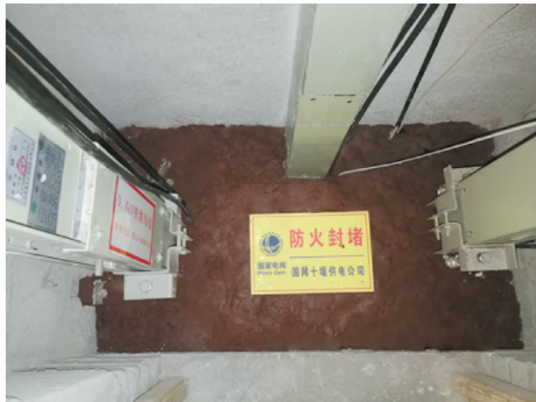
电缆井治理后。
