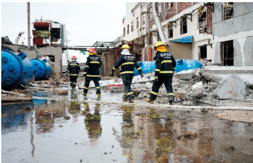
在爆炸事故现场,江苏消防救援总队盐城支队的队员仍未放弃搜救。
