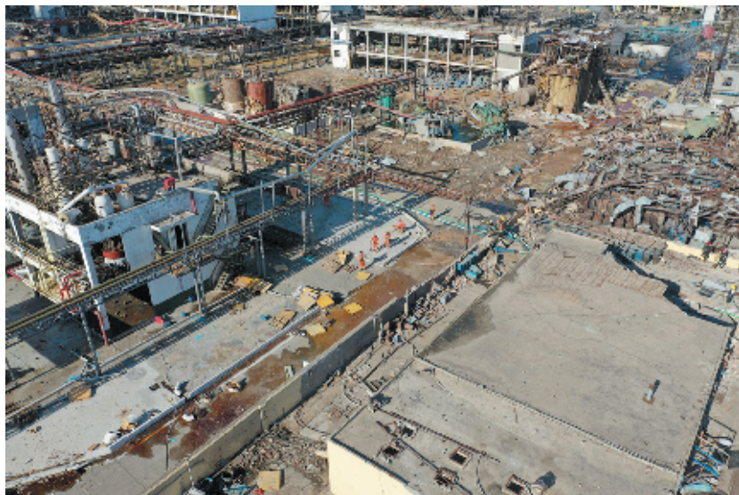
22日,消防队员在江苏盐城响水化工厂爆炸事故现场搜救(无人机拍摄)。
