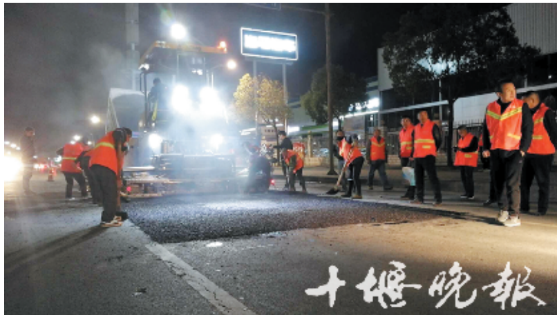
市政建设工人加班加点维护城区主次干道(资料图)。
