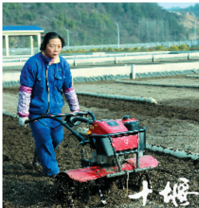
泗河人工快渗工程现场,工人在翻晾细沙。
