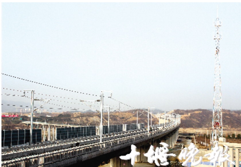
工人正加紧架设汉十高铁官山河特大桥旁的通信铁塔。
