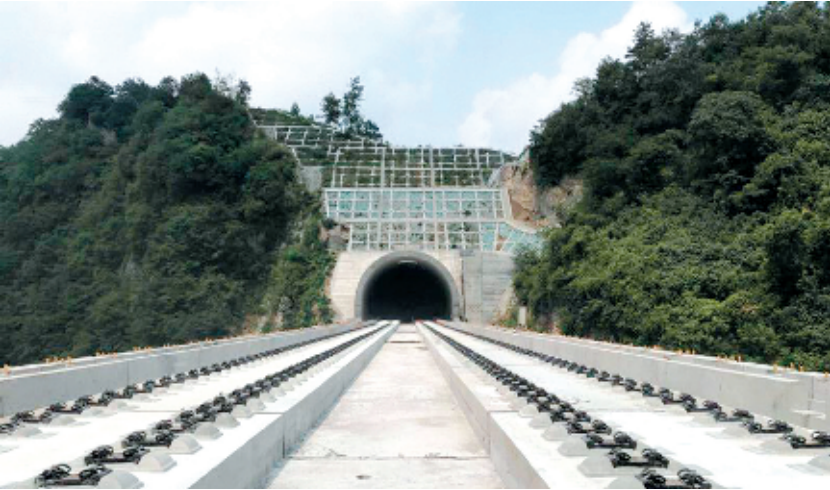
无砟轨道铺设快速推进为汉十高铁年底开通运营打下坚实基础。
