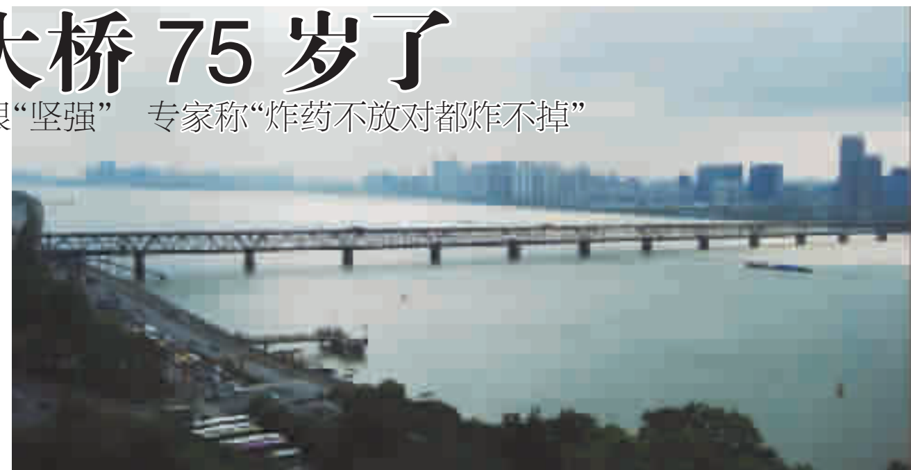
钱塘江大桥是中国历史上第一座自己设计并建造的现代化公路铁路两用特大桥。9月26日,它迎来了它的第75个年头。这75年来,任凭风吹浪打,它岿然不动,因此一度被网民称为“桥坚强”。
