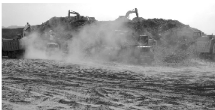
大型挖掘机正在开山。
